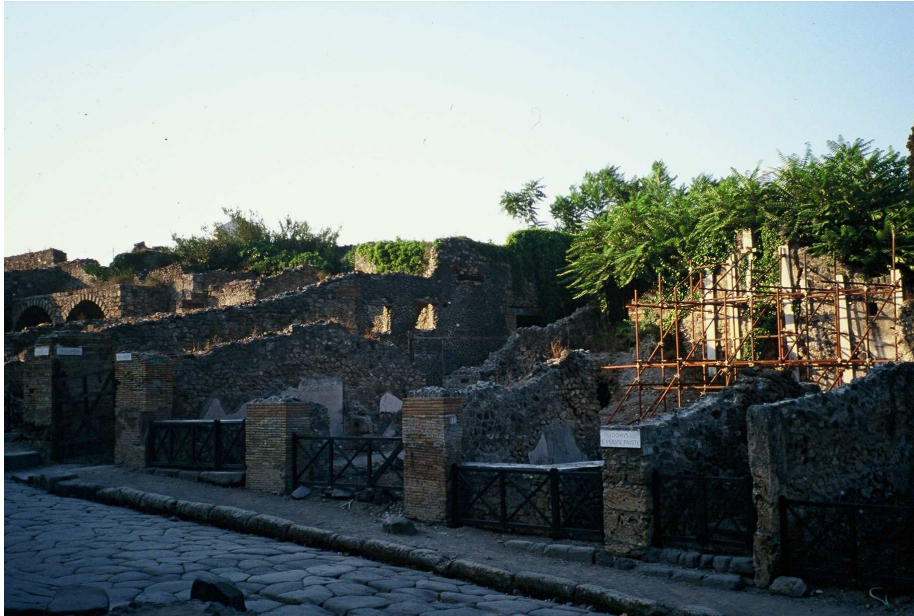
Figuur 4.8: Hier en daar worden muren overeind gehouden door stellingen (elders is de boel simpelweg ingestort).
